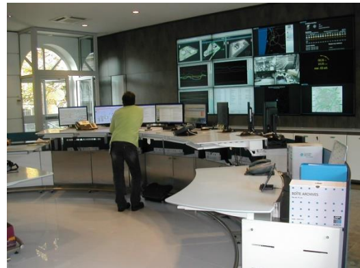
Console avec plan de travail et plan de pose des écrans monte et baisse. Vue arrière et côté opérateur
